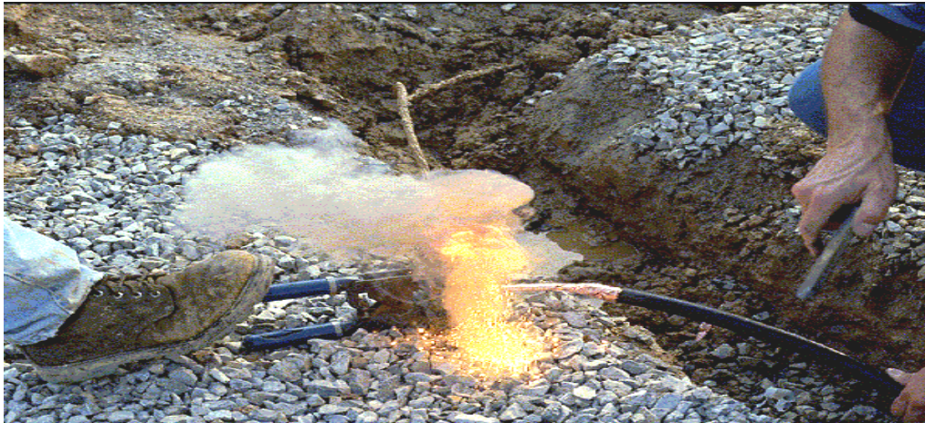
Figura 8 – Ejemplo de uniones por termofusión
